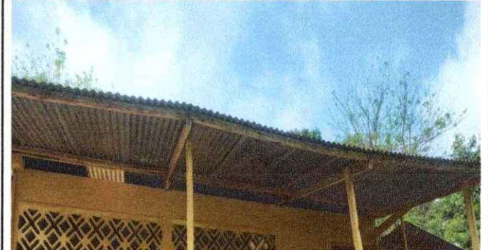
Foto 2: Sustitucion de costanera de madera por metal.
