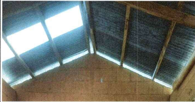
Foto1: Sustitucion de lamina normal por lamina troquelada calibre 26
