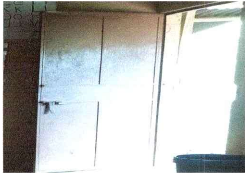
Foto 3: Cambio de puerta de metal
