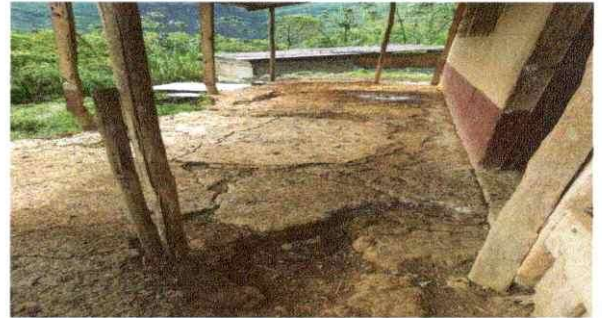
Foto 4: Mantenimiento de corredor de concreto.
