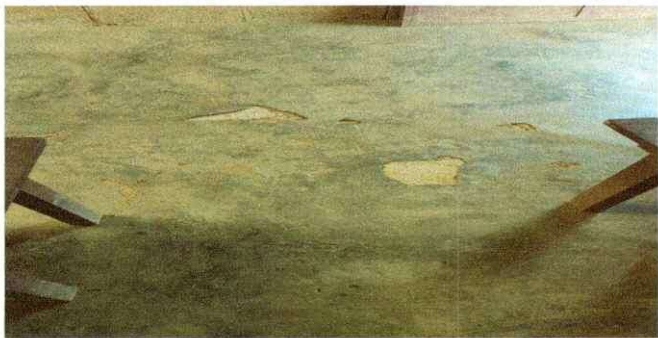
Foto 5: sustitucion de piso concreto por piso ceramica.
