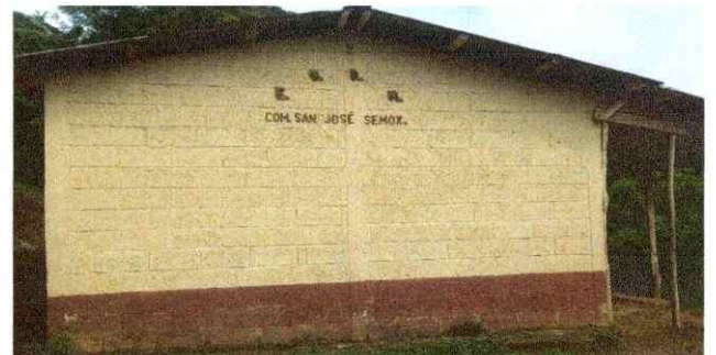
Foto 6: Mantenimiento de pintura del edificio (Exterior y interior).
